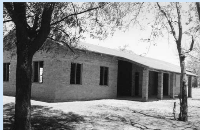
Hombolo-Tanzania: ecco la foto dell'asilo in costruzione inviataci da Maria Carla successivamente
